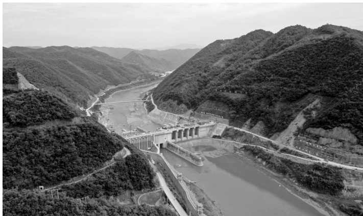
引汉济渭工程黄金峡水利枢纽
