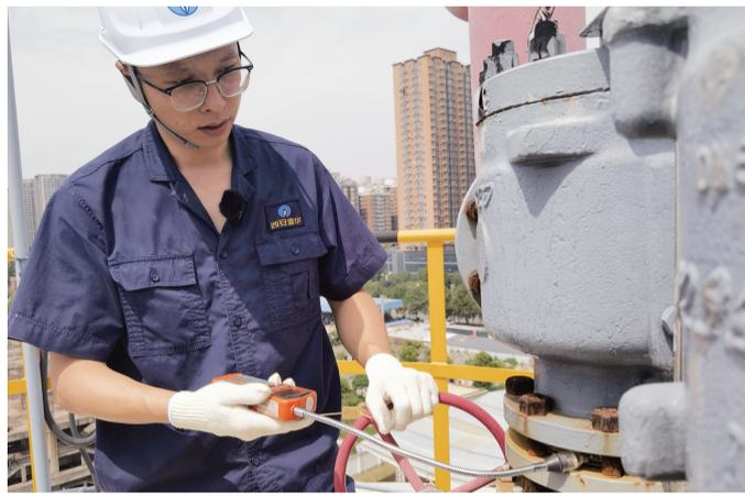
魏超用气体测漏仪对罐体顶端设备进行仔细巡检
