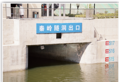
黄池沟配水枢纽秦岭隧洞出口 (7月16日摄)。 新华社发
