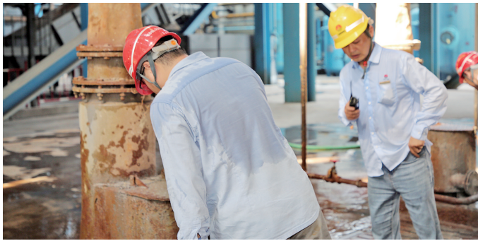
电力人员在高温下进行设备检修
