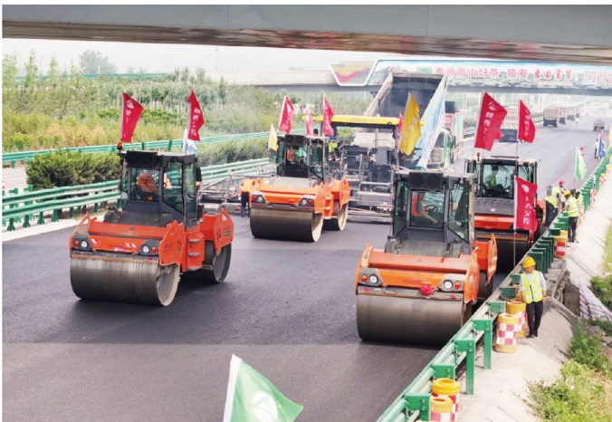
包茂高速曲江至太乙宫段改扩建项目沥青路面上面层试验段顺利铺筑。
