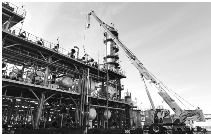
检修期间260吨吊车在厂区作业。
