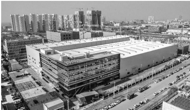
隆基氢能总装项目。
