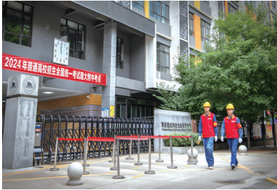
国网西安供电公司工作人员苗凡、苗佳乐正在对建大附中考点电力设备进行巡视检查。
