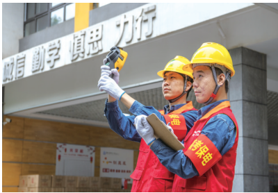
国网西安供电公司工作人员苗凡、苗佳乐正在对建大附中考点电力设备进行带电检测。
