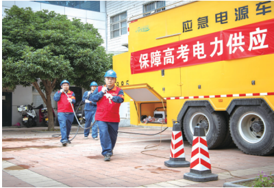
国网西安供电公司工作人员李军、安军权、苗凡在拉出中压发电车出线电缆。
