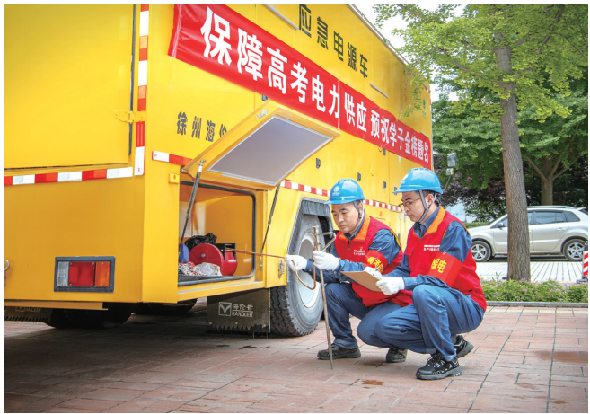
国网西安供电公司客户经理李军、安军权在检查中压发电车接地装置。
