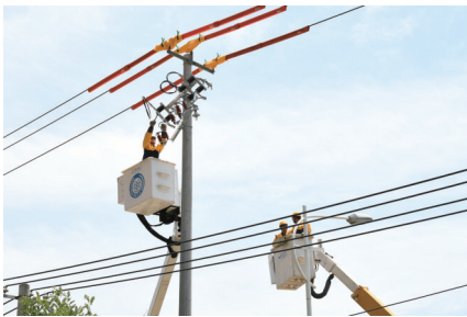
国网陕西电力员工开展带电作业。
