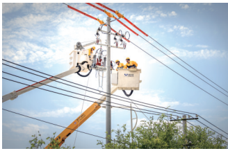
6月13日,国网西安供电公司带电作业中心在元奉一路10千伏兰三线,实施带电安装开关及搭头作业。
