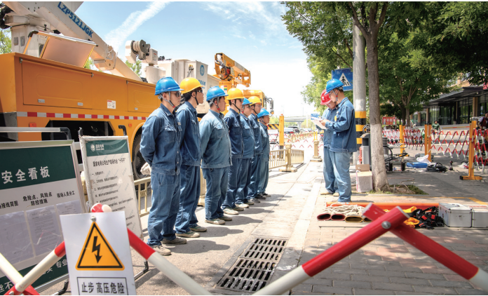
6月13日,国网西安供电公司带电作业中心在元奉一路,召开带电作业班前会。
