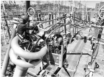
电力人员安装变电设备。
