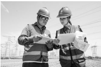
电力人员核对施工方案。
