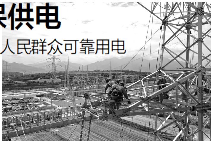
电力人员在高空作业。
