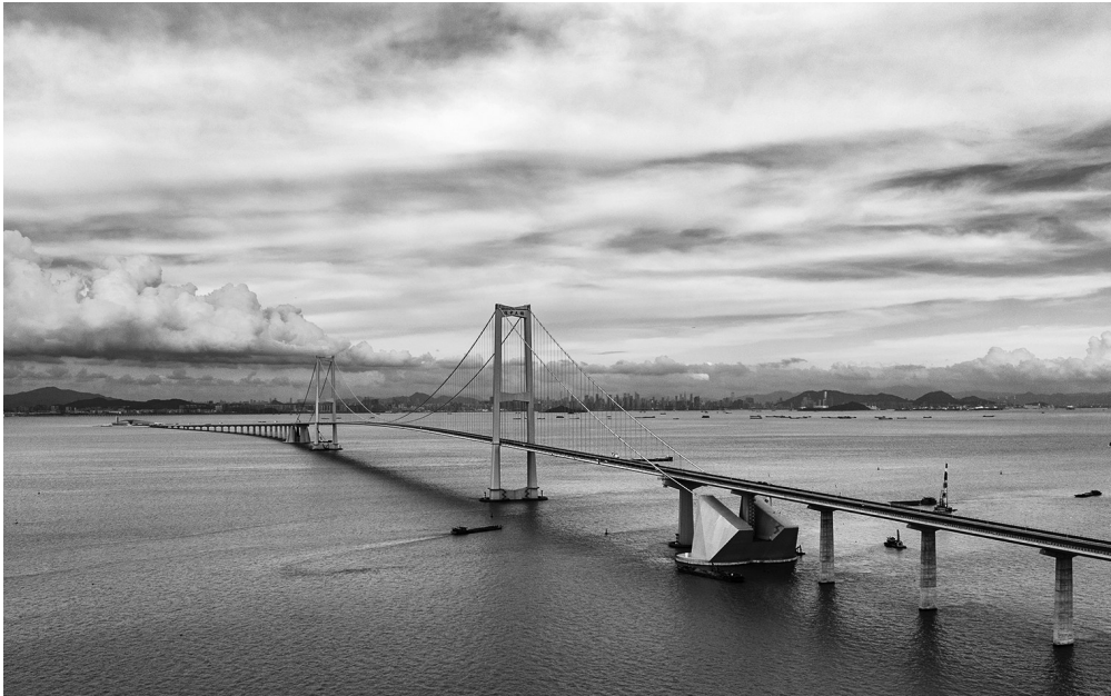
6月27日拍摄的深中大桥(无人机照片)。新华社发
