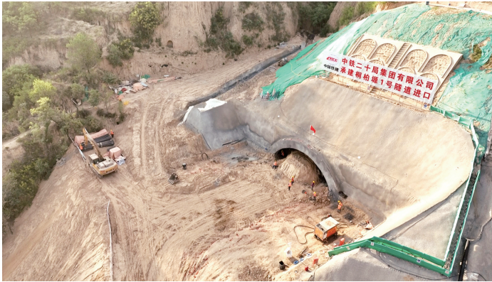
延榆高铁最长隧道开工建设。
