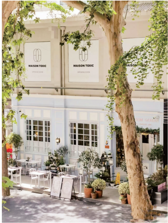
旧厂房原址上建西餐厅。
