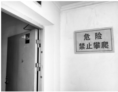
楼道贴着“危险 禁止攀爬”的提示。
