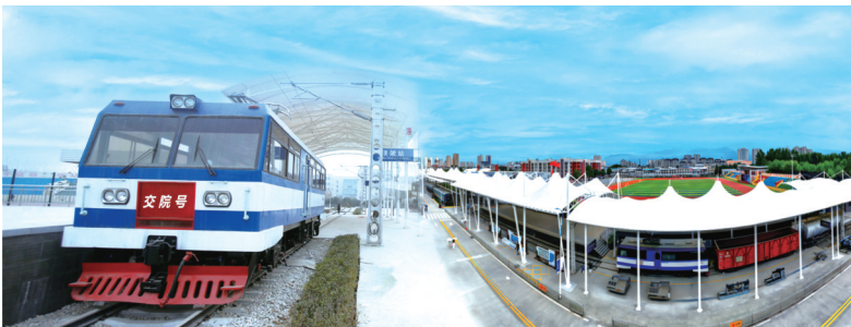
轨道交通综合实践基地。
