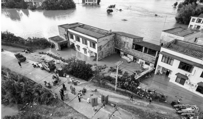
7月29日,在涓水湘潭县河口镇华中村堤段附近,抢险人员转移群众(无人机照片)。
