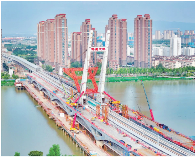
港盛大桥主体施工中。
