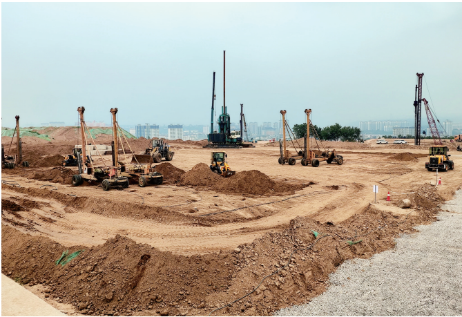
西延高铁铜川站开工建设。(西安铁路局供图)
