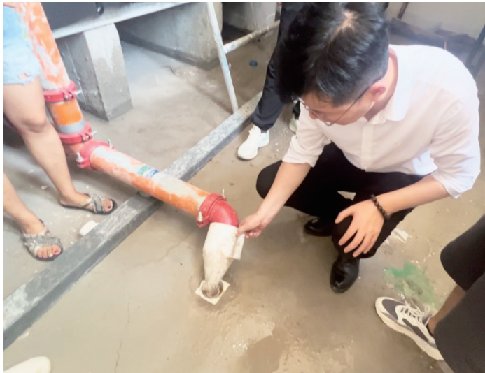
工作人员查看水箱管道。
