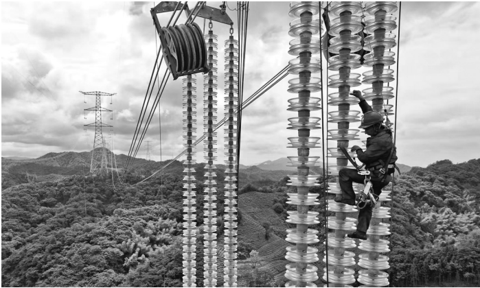
武汉-南昌1000千伏特高压放线施工。
