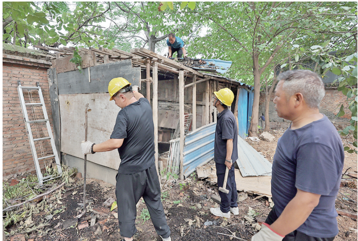
工人正在对简易棚进行拆除。
