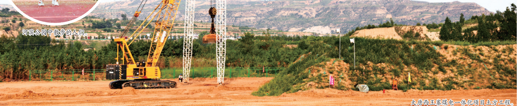
大唐西王寨煤电一体化项目土方工程。
