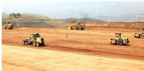
府谷机场项目建设现场。
