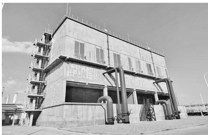
榆林化学DMC项目现场。
