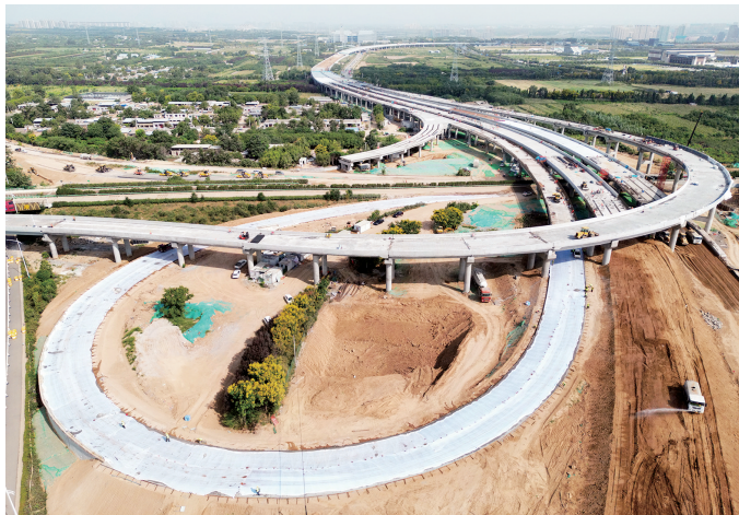
马家堡至泾阳高速施工现场,工人正在加班加点施工。
