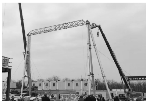
330千伏泾河变电站工程进行构架吊装。姚军摄
