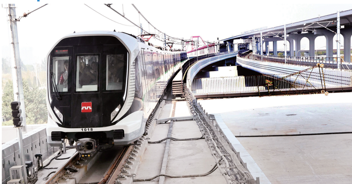
西安地铁10号线列车驶进车站。本组图片由本报记者 阮班慧 摄
