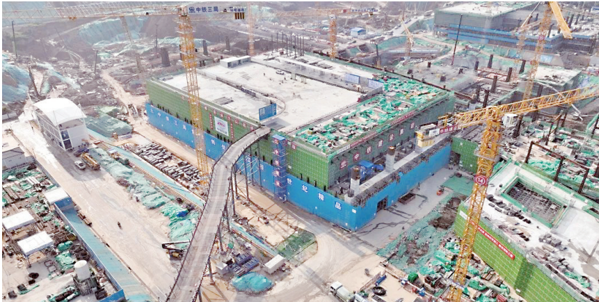
西安东站施工现场。
