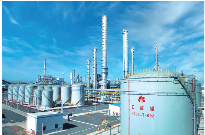
延长石油榆神年产50万吨煤基乙醇项目。
