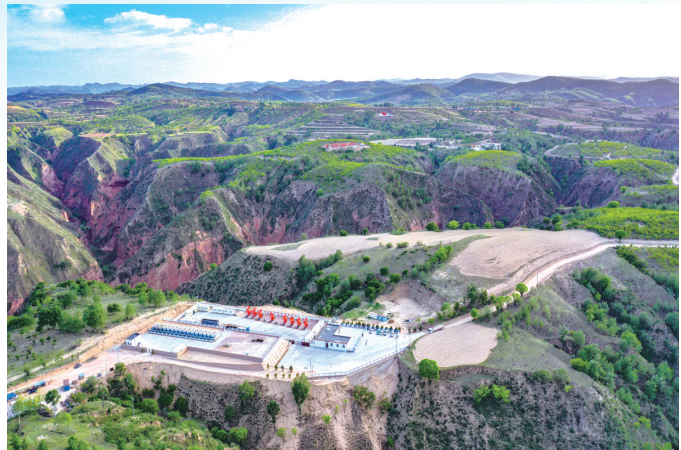
延长石油靖边采油厂数字化井场。
