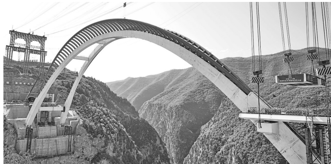
陕西东庄水利枢纽泾河大桥悬吊段空中拼装施工。
