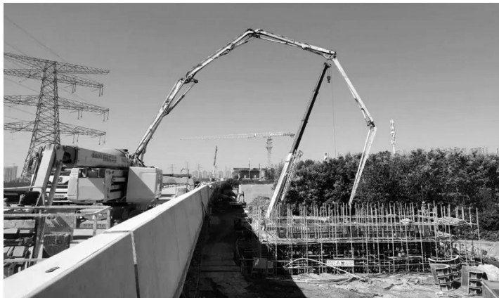
马家堡至泾阳高速项目渭河特大桥右幅浇筑混凝土。
