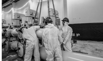
施工人员正在进行户内GIS设备安装。吴一楠摄
