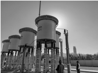
施工人员正在进行电抗器复检。吴一楠摄
