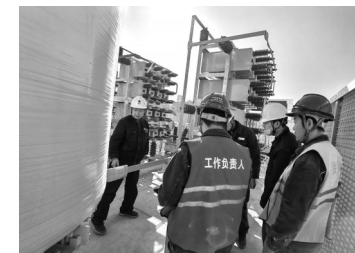
施工人员正在进行硬母线验收。吴一楠摄
