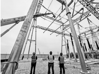
施工人员正在进行软母线附件安装。吴一楠摄
