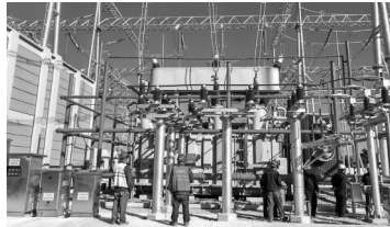
施工人员正在进行主变消防管道复检。吴一楠摄
