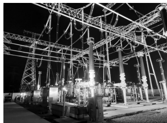
夜间施工中的西塬330千伏变电站。高翔摄
