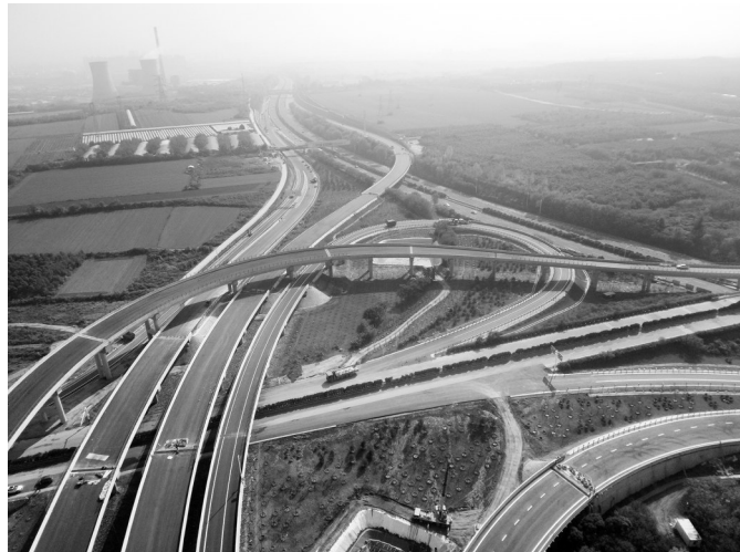
马家堡至泾阳高速公路施工已进入尾声。
