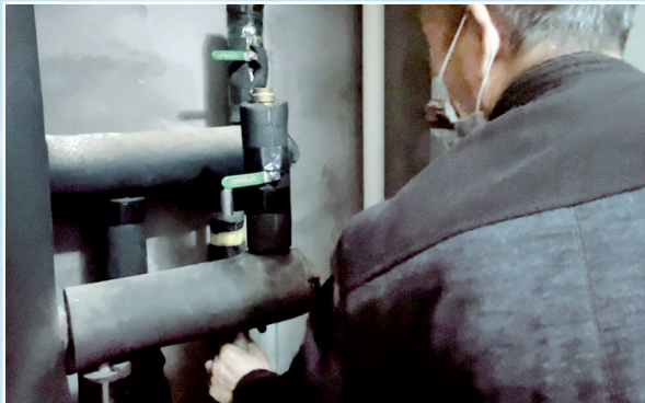
在查看供暖管道。 中铁缙香郡小区3号楼住户正
