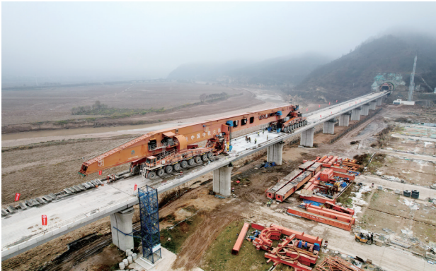
施工现场。 岳建伟摄
