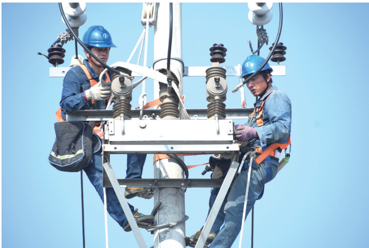
国网陕西电力员工进行电网改造。
