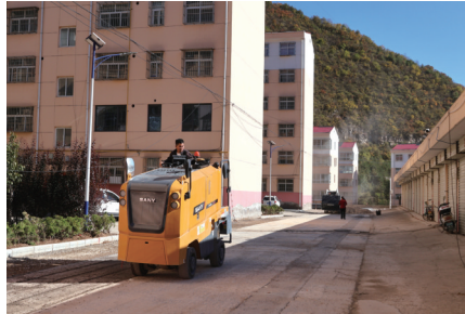
麻地湾村安置小区道路改造中。
