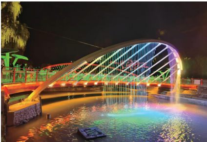
刚刚建设完工开通的“爱情桥”。
