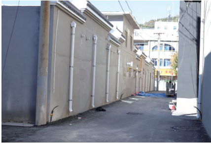
南河滩片区“黄龙胡同”雨污分流施工现场。
