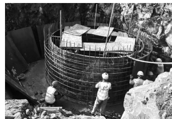
永富灌区黑漆河茶园水源大口井施工。
