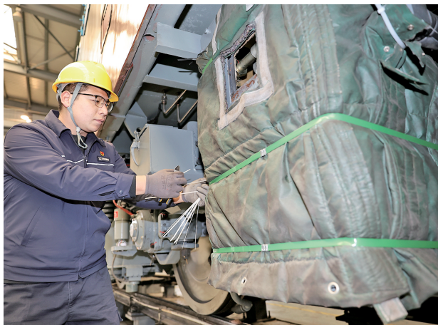
西安机务段检修车间工作人员对列车空气干燥箱进行保温处理。 本报记者 马昭 摄
