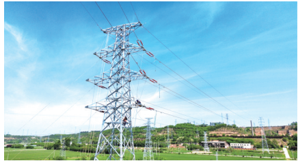
国网陕西电力进行高空架线。
