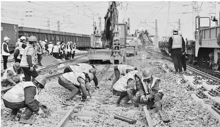
施工现场。 本报记者 马昭 摄
