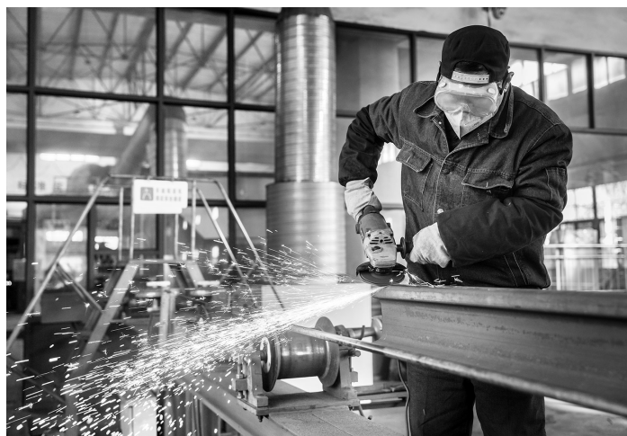
工人进行焊接作业。
