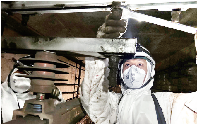
叶建勇在隧道内进行接触网维修作业。
