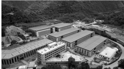
留凤关循环经济园区外景。
