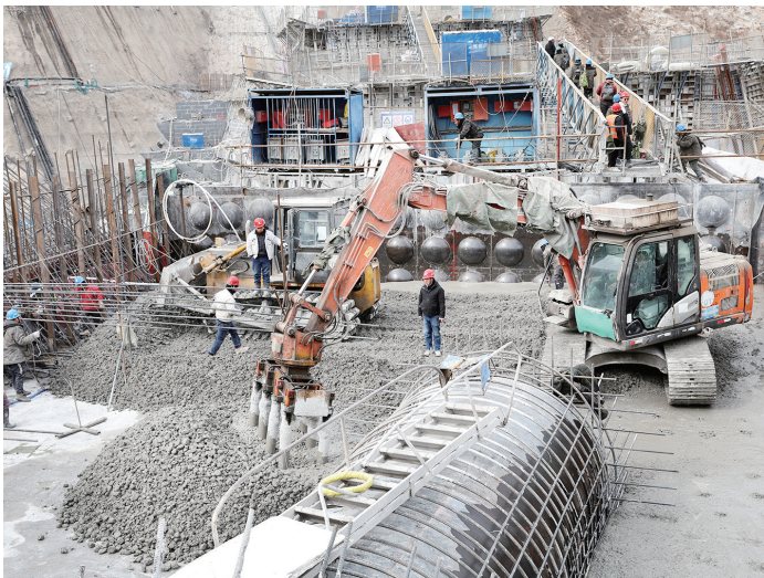
施工现场工人们正在进行大坝浇筑。 本报记者 马昭 摄
