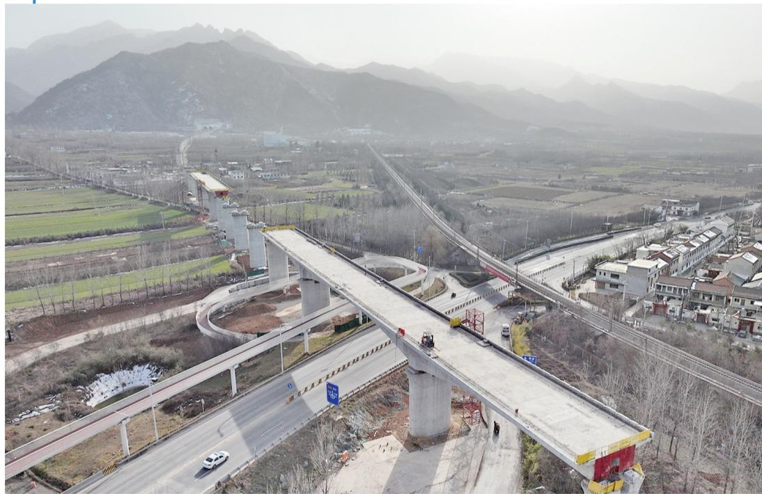
新春伊始,西康高铁各项目部施工建设有序推进。记者从西康高铁建设管理单位西成客专陕西公司了解到,截至目前,西康高铁全线隧道正洞开累完成设计总量的92.7%;全线桥梁工程开累完成设计总量的77.9%;路基工程完成设计总量的88.4%。图为建设中的西康高铁关中环线立交特大桥(2月7日摄,无人机照片)。
