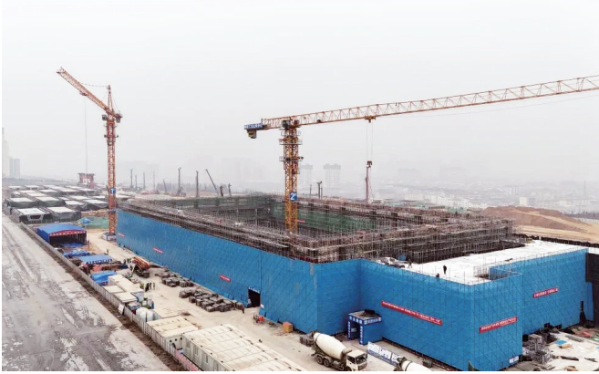
西延高铁铜川站站房主体结构。
