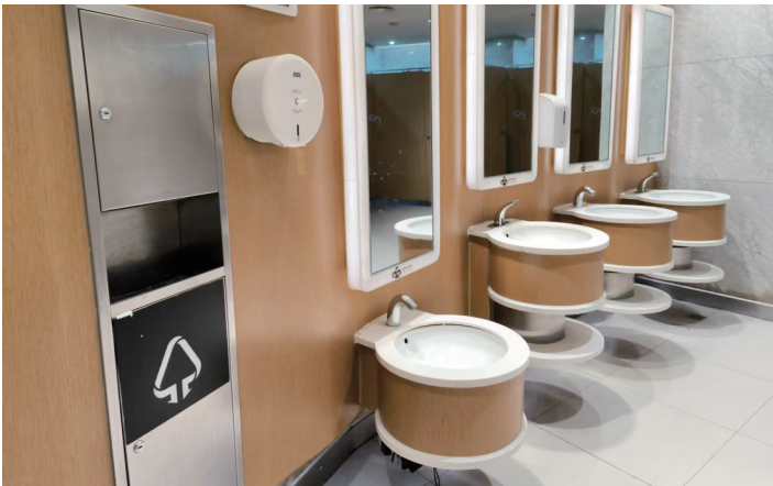
龙首印象城卫生间水龙头流出的只有凉水。
