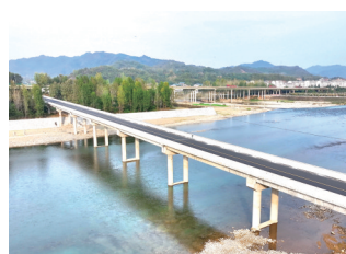
过风楼镇丹江大桥建成通车。
