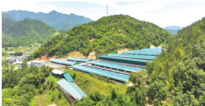
城关街道捉马沟梅花鹿产业园。
