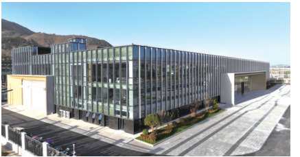
中天禹辰高端无人机制造产业园项目(一期)。
