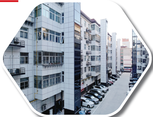
改造后的老旧小区焕然一新。
